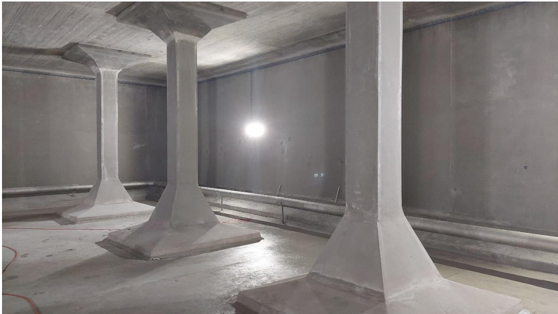
Abbildung 4: Baustelle in der Kammer 1 mit neuer Beschichtung
