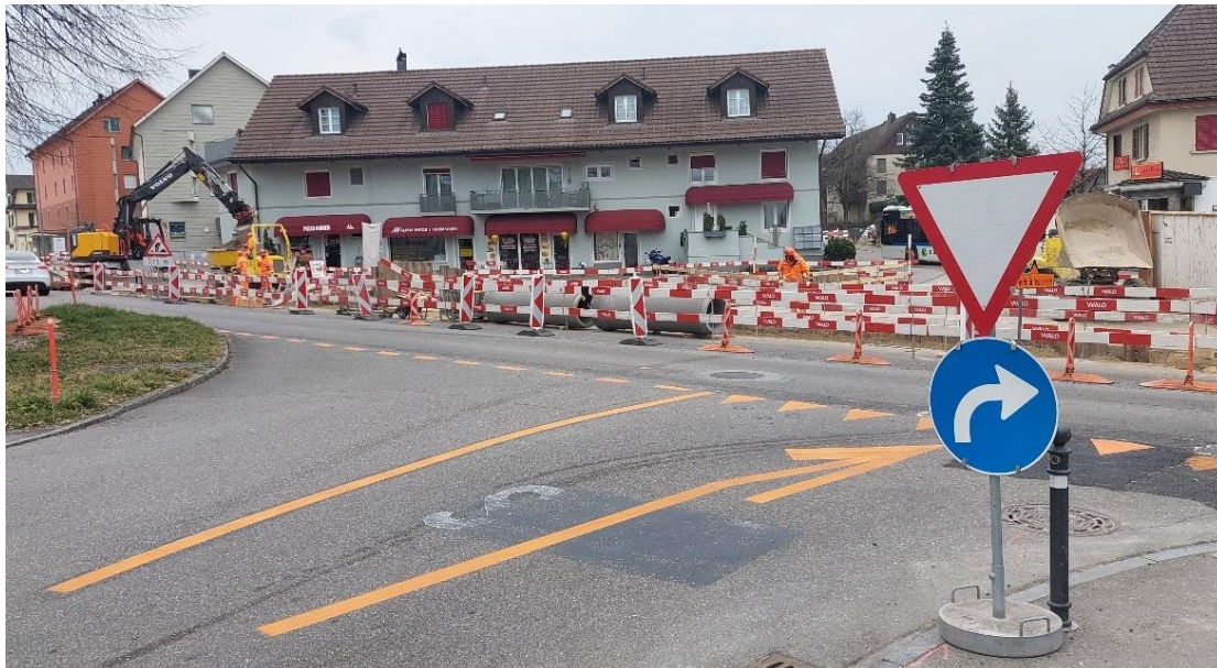
Abbildung 10: Baustelle der ersten Etappe an der Zürichstrasse in Brüttisellen
