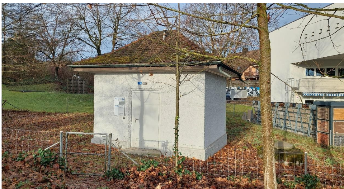
Abbildung 8: Pumpwerk Rikon, Effretikon
