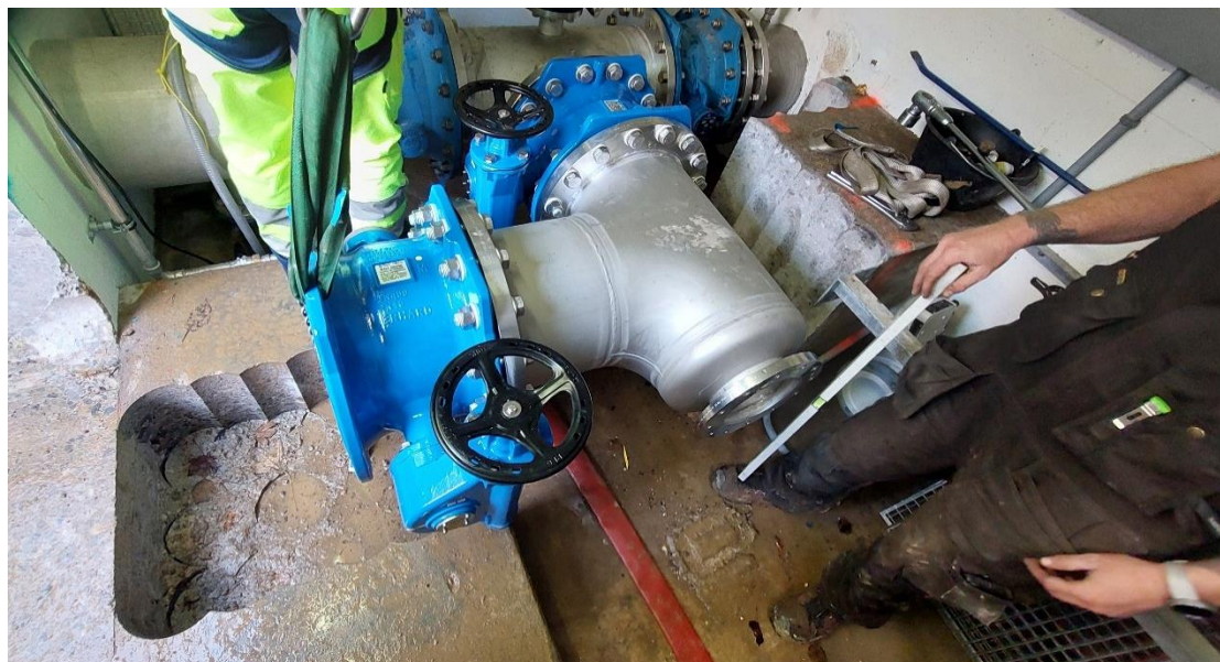
Abbildung 14: Baustelle Einbau neues T-Stück im MS Thonäcker
