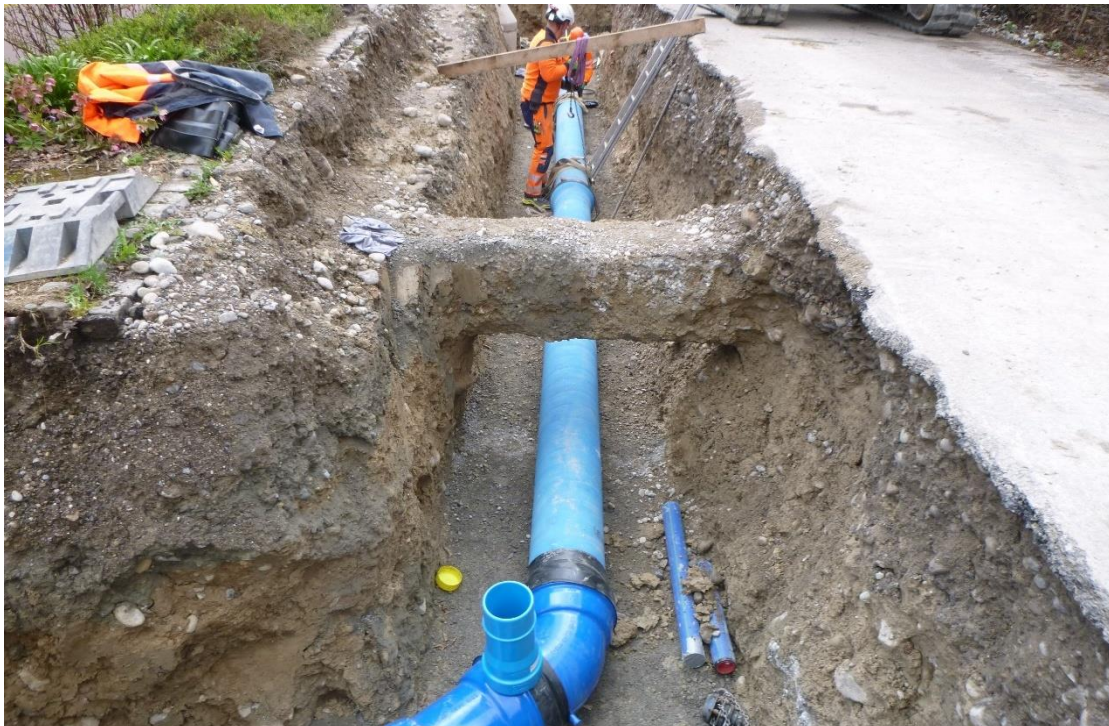
Abbildung 9: Baustelle Leitungsersatz Rainstrasse, Effretikon
