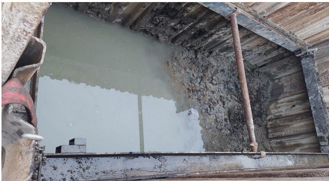
Abbildung 12: Startgrube beim Altbach
