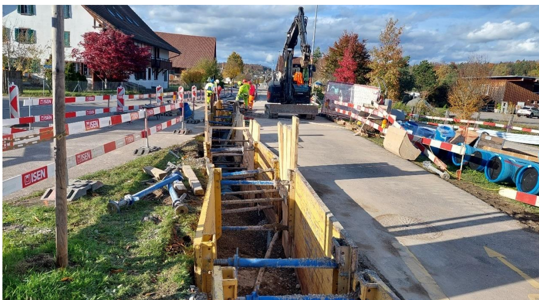
Abbildung 13: Baustelle der vierten Etappe an der Bassersdorferstrasse
