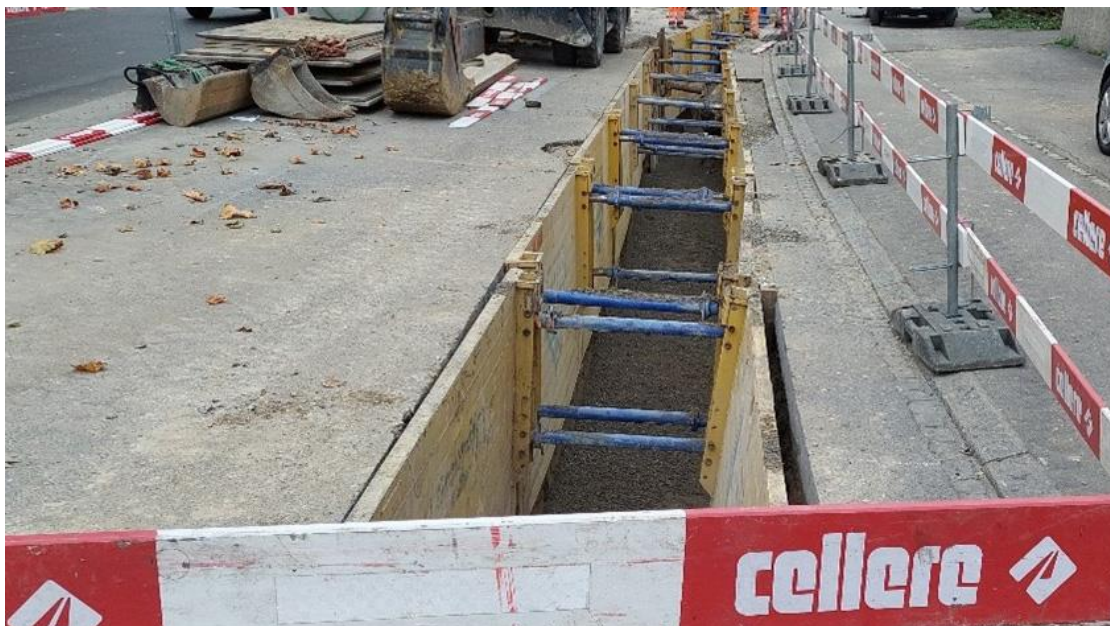
Abbildung 11: Baustelle der dritten Etappe an der Bahnhofstrasse in Dietlikon
