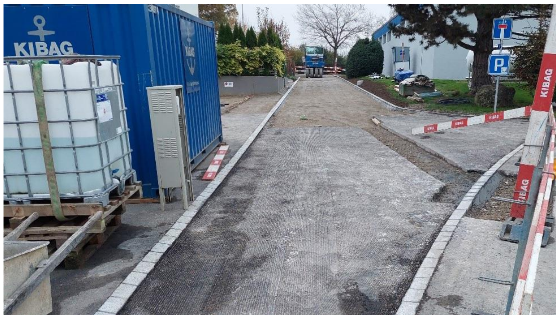
Abbildung 5: Baustelle Leitungersatz Hackenbergstrasse
