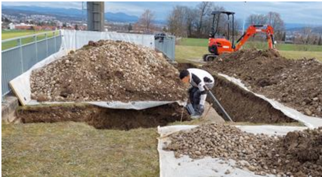
Abbildung 4: Reservoir Tambel – Abdichten der Decke
