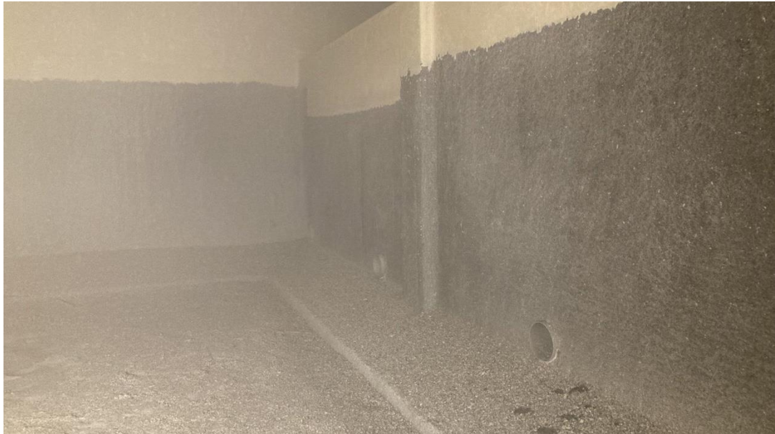
Abbildung 3: Kammersanierung - Abstrahlen der Beschichtung
