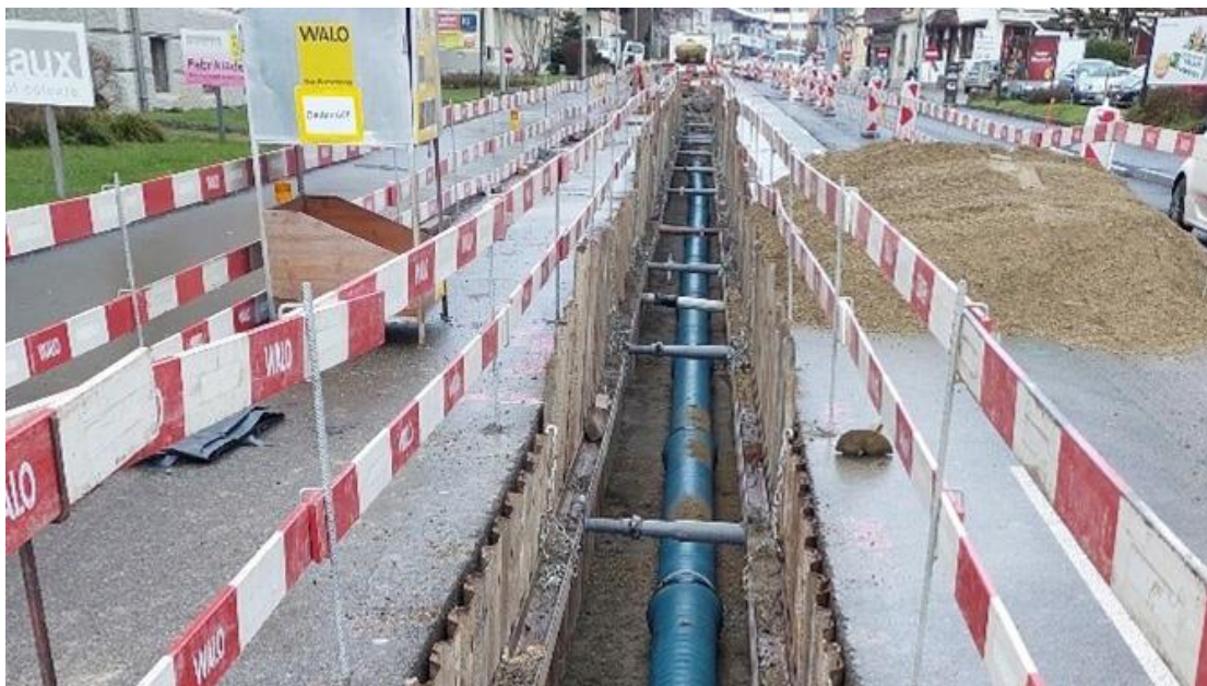
Abbildung 8: Baustelle der ersten Etappe an der Zürichstrasse in Brüttisellen
