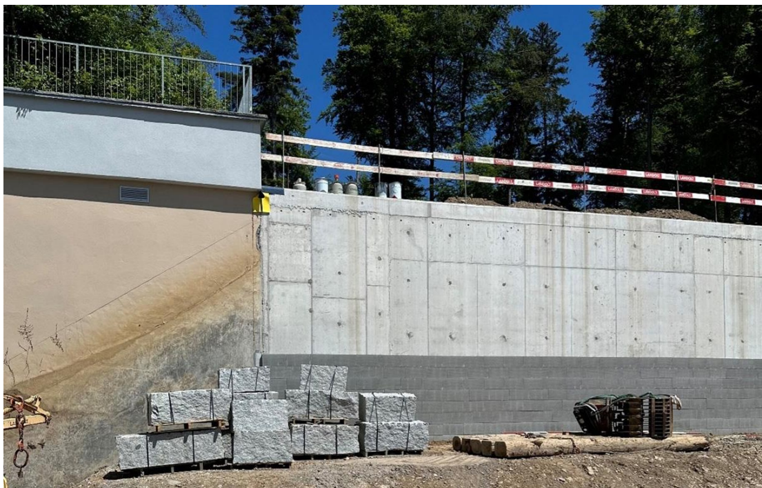
Abbildung 1: Baustelle Kammer 3, Reservoir Lattenbuck
