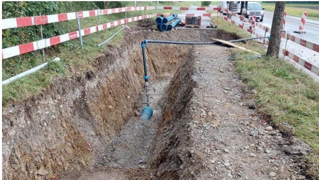
Abbildung 6: Baustelle Leitungsgaben mit Spülvorrichtung
