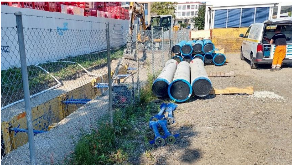
Abbildung 9: Baustelle der zweiten Etappe am Fabrikweg in Brüttisellen
