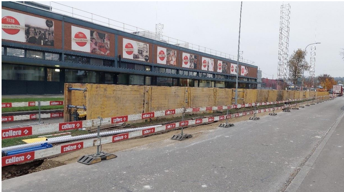
Abbildung 10: Baustelle der zweiten Etappe an der Brüttiseller-/ Stationsstrasse in Dietlikon
