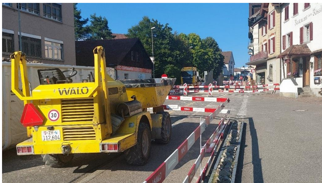
Abbildung 7: Baustelle der ersten Etappe an der Zürichstrasse in Brüttisellen
