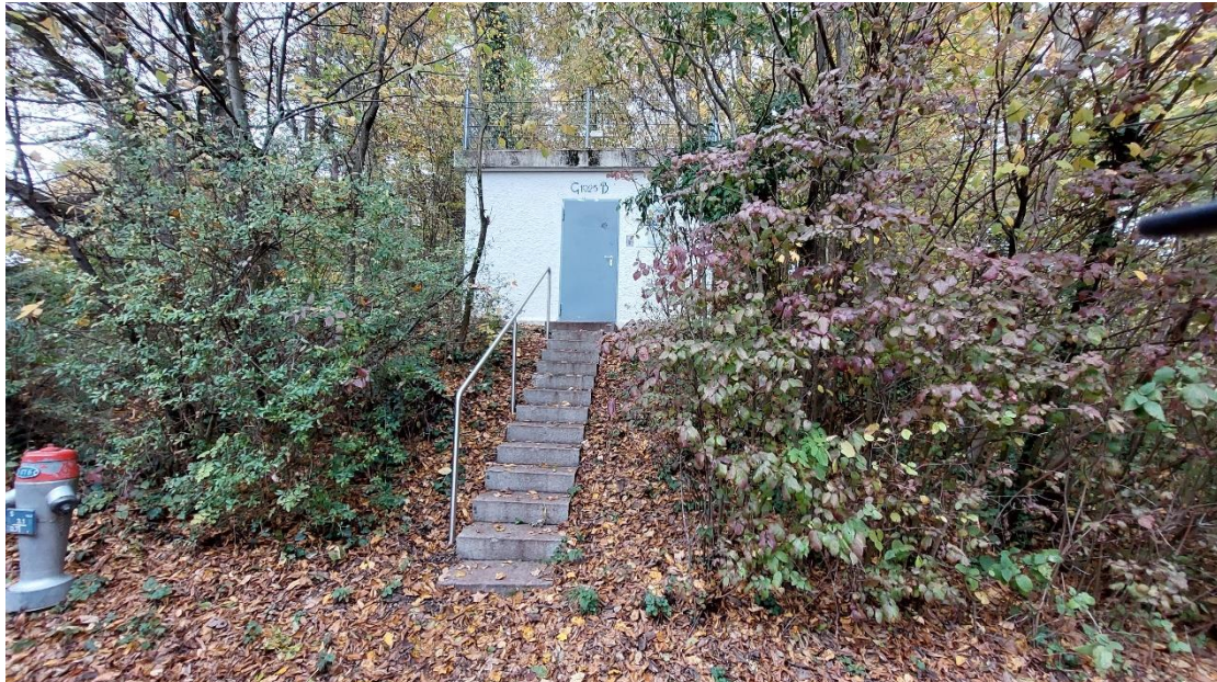
Abbildung 4: Handlauf Aussentreppe Reservoir Geisshügel
