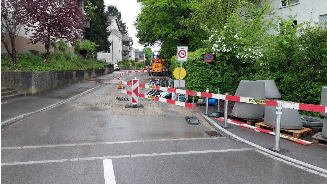
Abbildung 13: Baustelle Huebstrasse, Tagelswangen
