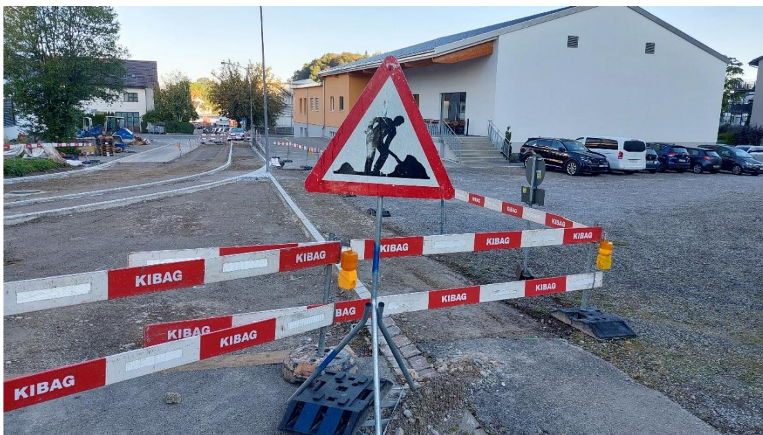
Abbildung 12: Baustelle Breitistrasse, Effretikon
