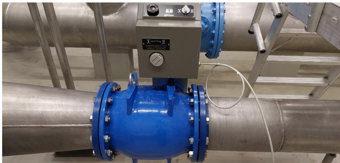
Abbildung 2: Ringkolbenschieber
